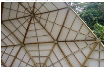
21- Geodésica – Serra da Cantareira Arquitectura: Andagio Empreendimentos Criativos Local: Mairiporã, SP- 2014
