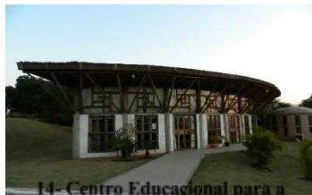
14- Centro Educacional para a Sustentabilidade - Alphaville Arq.: Marcelo Todescan, Frank Siciliano Construcción: [bambu]: Robert Harris Local: Santana de Parnaíba, SP-2008
