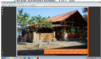
9- Centro Comunitário de Cambury Arquitectura: SvenMouton Cálculo estrutural: Prof. KhosrowGhavami Local: Ubatuba, SP - 2006
